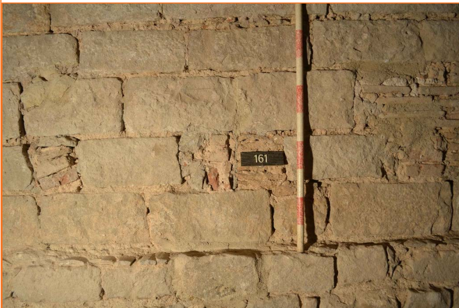
Foto 30. Detall forats de biga tapiats parament UE 146 planta 3.
