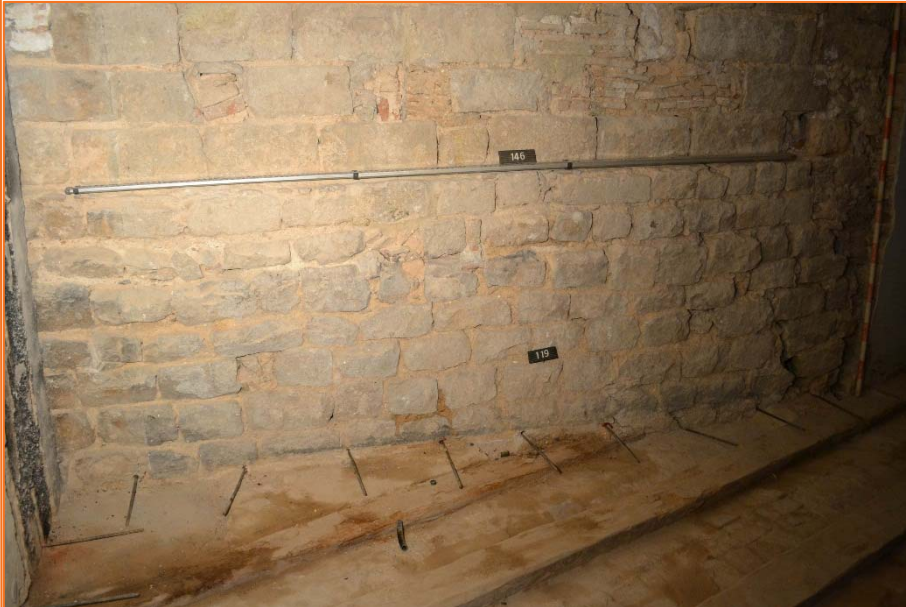
Foto 29. Detall paraments UE 119 i UE 146 planta 3
