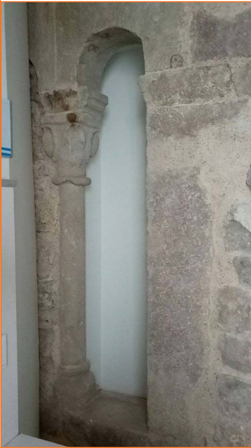
Foto 31. Vista de la finestra UE 122 un cop restaurada. Planta 2.
