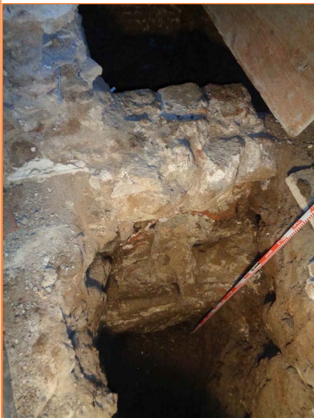
Foto 39. Dipòsit ja excavat per l'obra amb el mur UE 202 al tall. Passadís.
