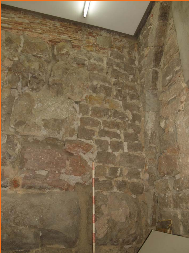
Foto 23. Arrencament de l'arc UE 101 en el lateral de la torre 66 documentat a l'edifici de Banys Nous 16
