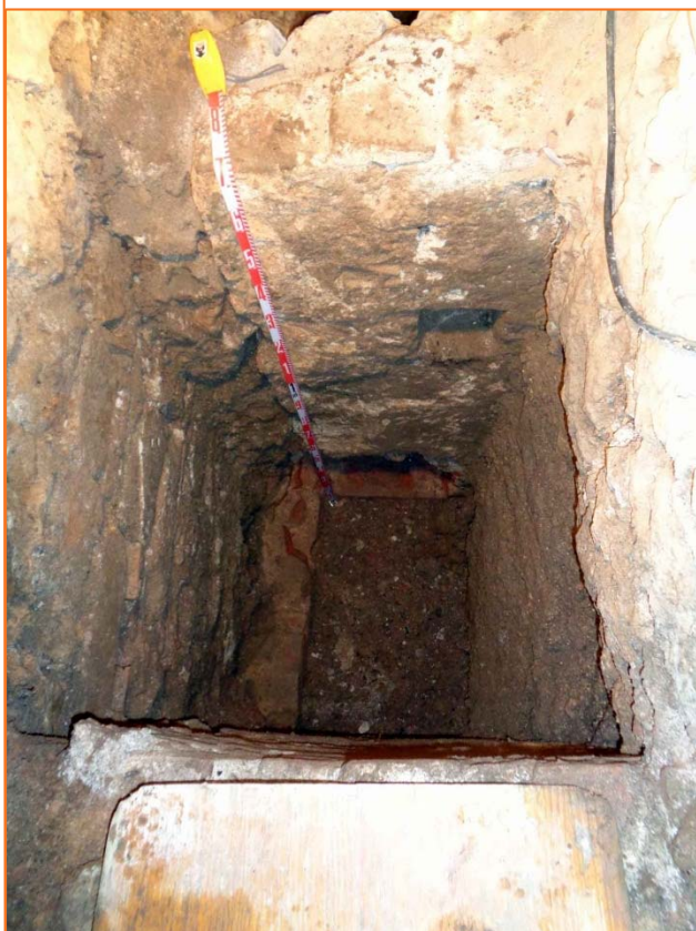
Foto 37. Dipòsit ja excavat per l'obra. Passadís.
