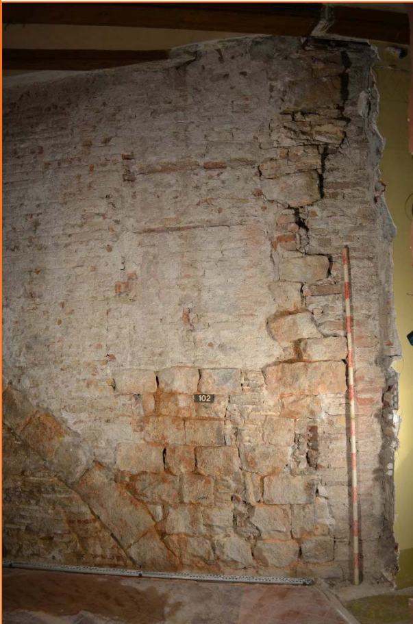
Foto 21. Parament UE 102 planta 1
