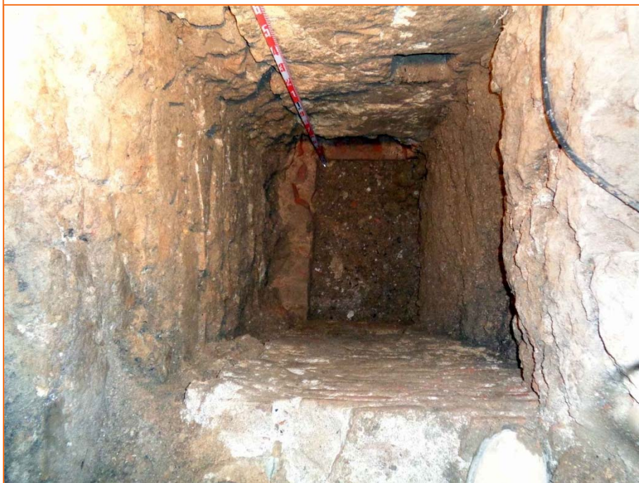
Foto 36. Dipòsit ja excavat per l'obra. Passadís.
